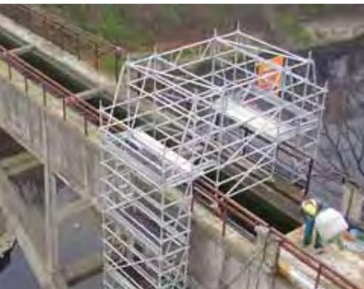
Con il ponteggio **multidirezionale MP** si possono realizzare anche delle torri mobili su ruote piroettanti per interventi speciali di manutenzione e restauro.
