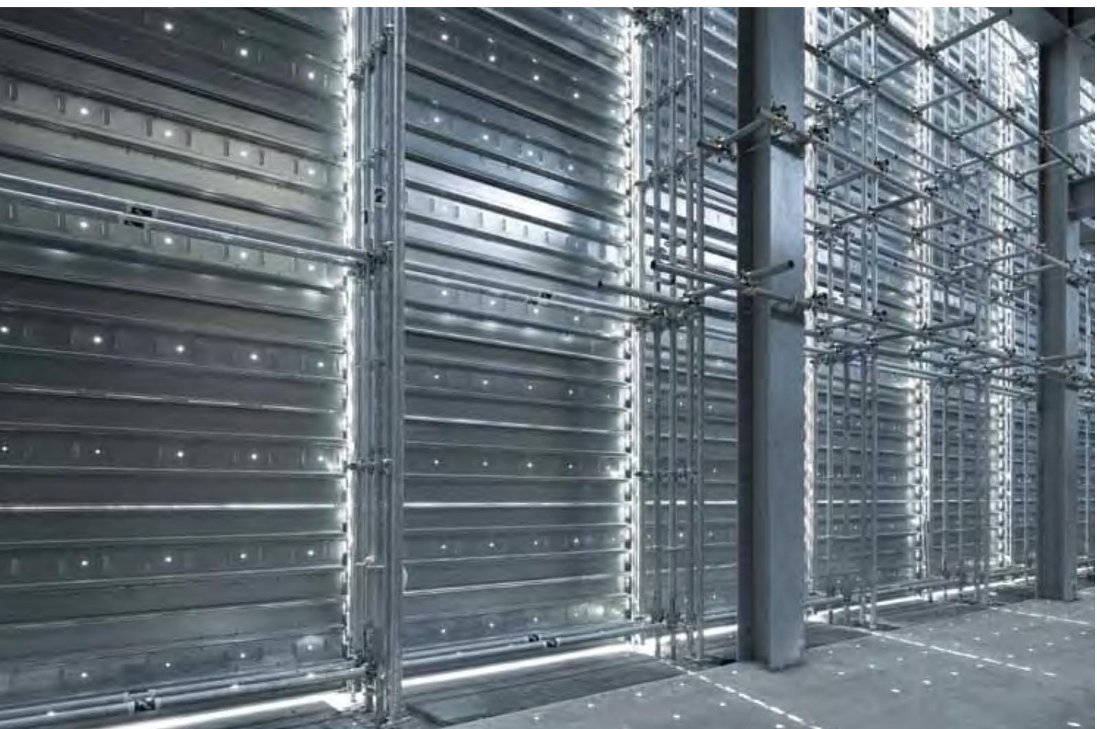
*Trasposizione tecnologia del ponteggio multidirezionale MP per la realizzazione del rivestimento di una struttura architettonica. Le tavole sono state usate in verticale per creare un volume provvisorio chiuso. Pilsio ha studiato dei pezzi speciali per questo particolare progetto.*
