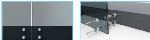
Noktasal tutucular döşeme alına M10 saplamalar ile monte edilir. Tutucumuz, akıllı tasarımlı sayesinde düşey-yatay, ileri-geri 10 mm'ye kadar hataları tolere edebilmektedir.
